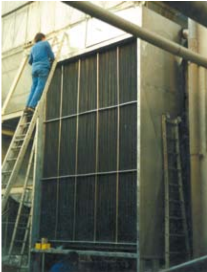
Duct heater 4 000 kW for dehydration in the agricultural industry Batterie chauffante 4 000 kW pour déshydratation dans l'industrie agro-alimentaire.
